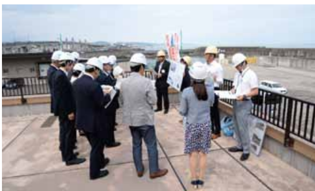
▲建設中の漁港の駅「TOTOOCO小田原」見学の様子
